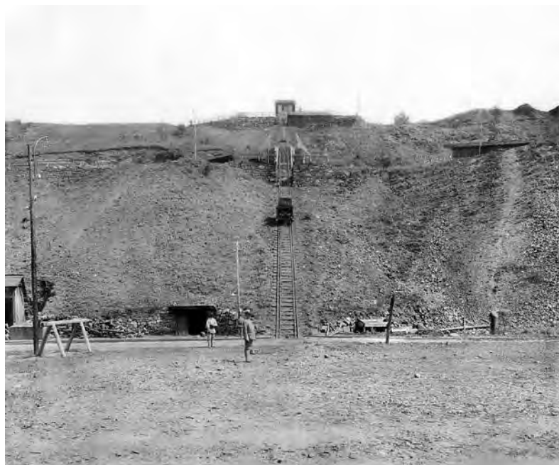
Figura 1.17. Ghelari, plan înclinat mina principală
