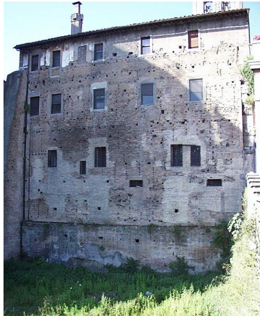
Fig. 5 - Peretele pe care planul de marmură a fost fixat, se pot vedea urmele pieselor de bronz care susțineau cele 150 de plăci, de asemenea se poate aprecia dimensiunea acestui plan al Romei.
