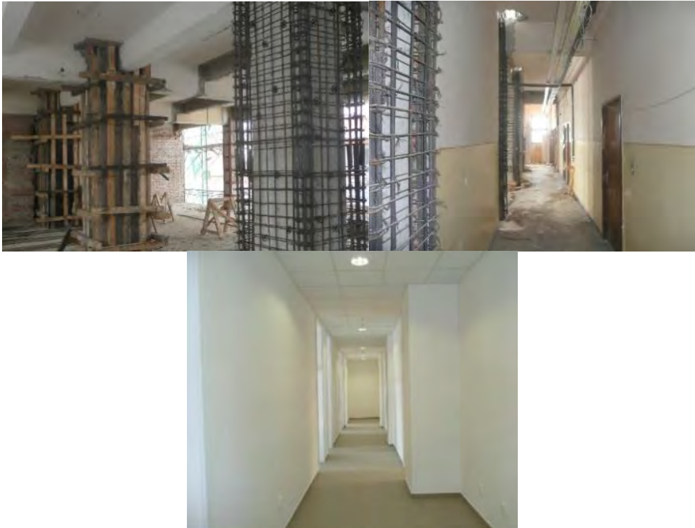
Fig. 5.75 Cămășuirea stâlpilor din beton armat
