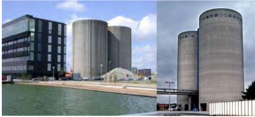
Fig. 2.31 Silozurile înainte de reconversie [134]
