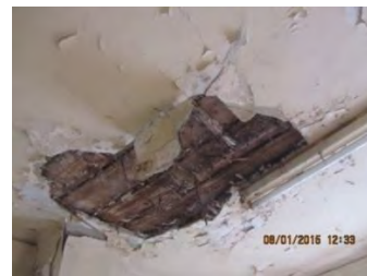
Fig. 5.20 Suprafața degradată la planșeu peste parter
