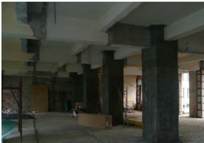
Fig. 5.76 Cămășuirea grinzilor din beton armat
