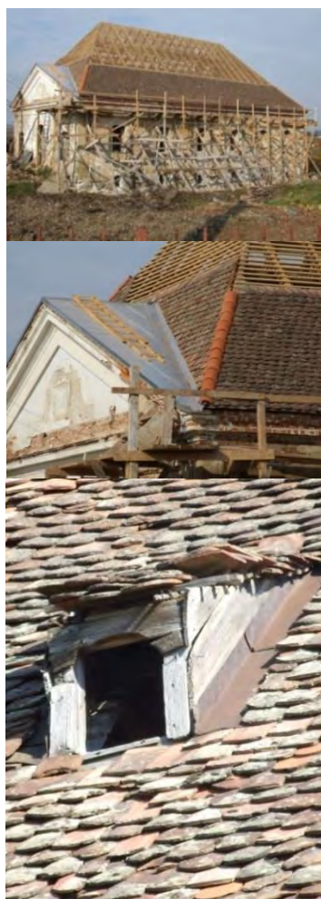
Fig. 2.40 a Refacerea șarpantei morii[137, 138]
