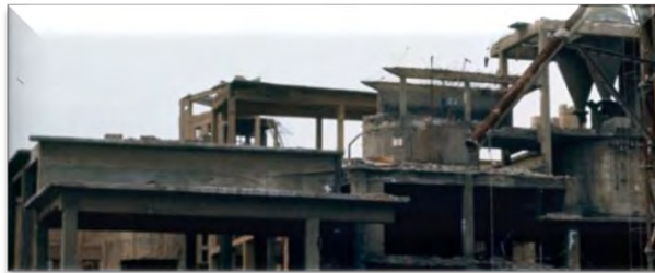
Fig. 2.20 Planșee monolite din beton armat [128]
