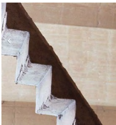
Fig. 2.23 Scări beton armat monolit [128]
