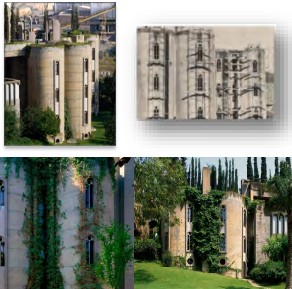
Fig. 2.30. Vederi, după consolidarea elementelor structurale [128]
