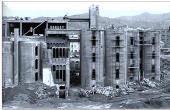
Fig. 2.19 Fabrica de ciment din Barcelona [128]
