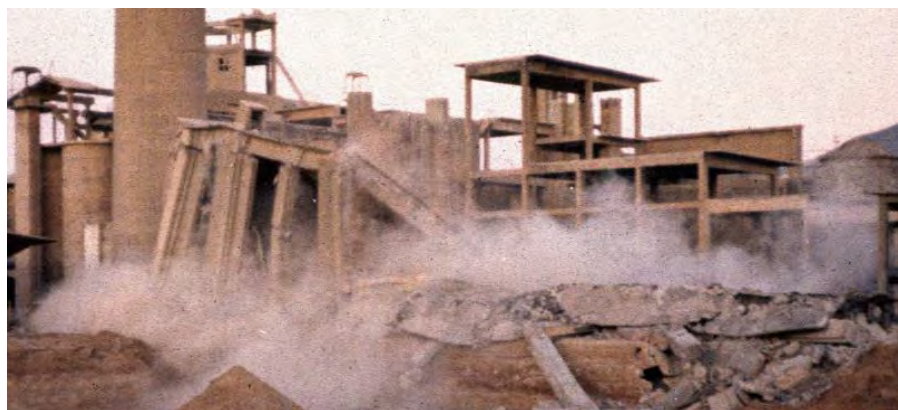
Fig. 2.25 Demolarea parțială a structurii [128]
