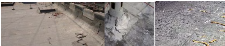
Fig. 5.34 Îmbătrânirea materialului bituminos
