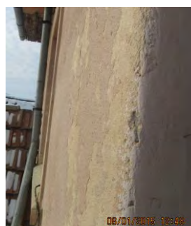
Fig. 5.4 Tencuiala degradată
