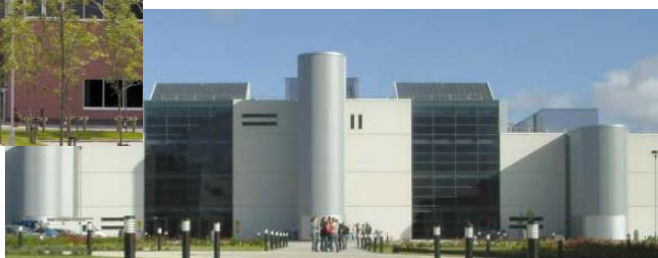
Fig. 2.12 Clădiri din sectorul nerezidențial realizate închideri din panouri de tip sandwich [70]
