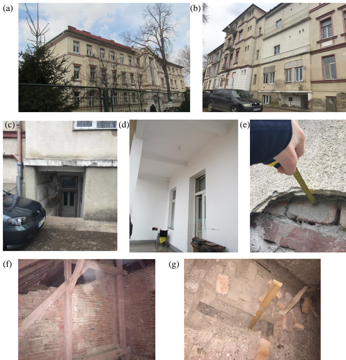
Fig. 6.44 Imagini ale clădirii 2 (a) Fațada SE – fațada principală; (b) Fațada NV; (c) Acces secundar, fațada NV; (d) Planșeu terasă circulabilă peste parter; (e) Tencuială exterioară, fațada SE; (f) Pereți spre spațiu neîncălzit (dinspre casa scării spre pod); (g) Stratificație planșeu de pod
