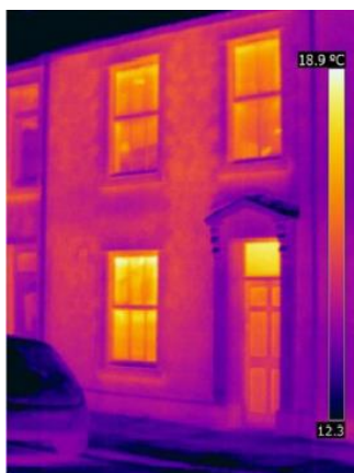
Fig. 2.7 Imagine termografică a fațadei unei clădiri [60]
