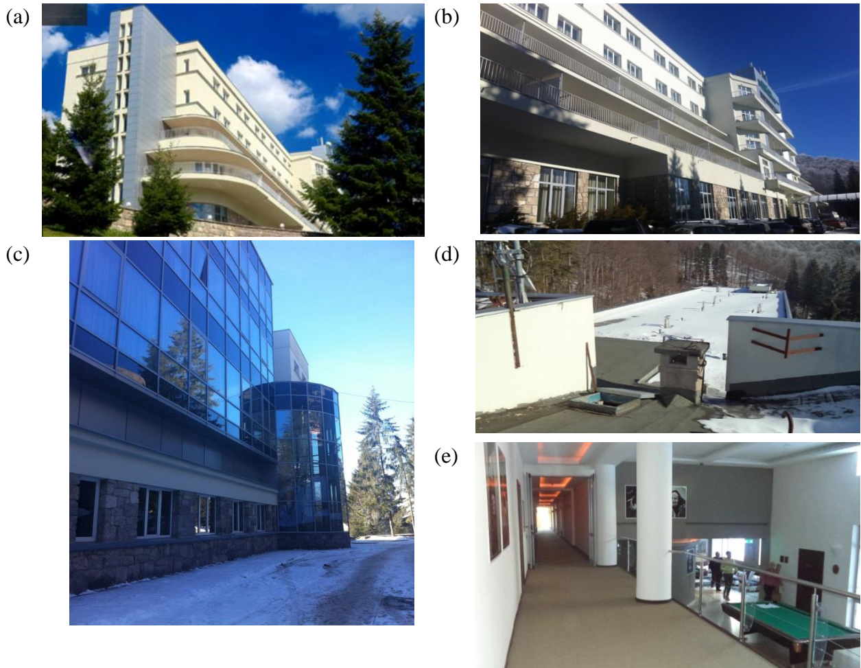
Fig. 6.26 Imagini ale clădirii I.B: (a) Fațadele Sud și Vest ale clădirii; (b) Pereți exteriori fațada Sud; (c) Fațada Nord – pereți cortină; (d) Partea estică a acoperișului terasă la cota +16.75 m; (e) Et.1 și mezanin (stg. – zona de cazare, dr. – lounge)
