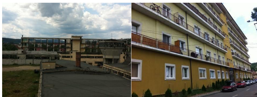
Fig. 2.11 Fostă hală din Cluj-Napoca transformată în bloc de locuințe cu păstrarea structurii de rezistență inițiale
