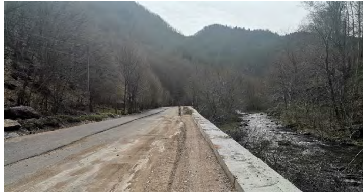
Figura 2. Lucrări de modernizare a DJ 764B.
