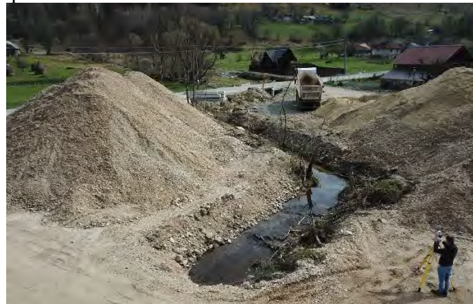
Figura 6. Efectuarea măsurătorilor cu stația totală prin metoda profilelor.
