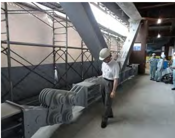
Amortizor seismic cu frecare
