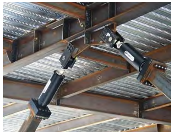
Amortizor seismic hidraulic (amortizare vâscoasă)
