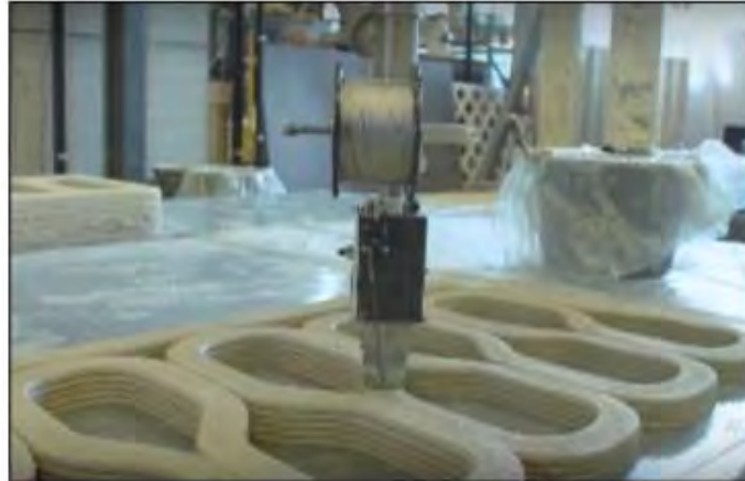
Figura 4. Împrimare cu cablu
