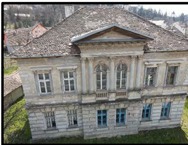
Fig.2 Obiectiv- Monumentul istoric “Casa istorică” str. Zaharia Boiu nr. 9
