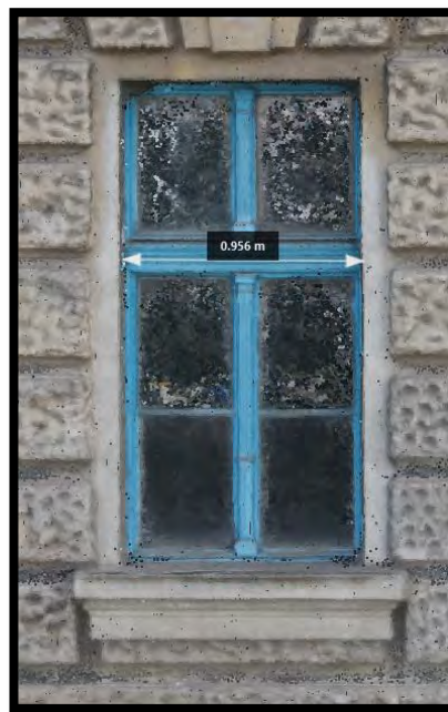
Fig.10 Distanța măsurată pe norul de puncte preluat cu ajutorul tehnologiei UAV
