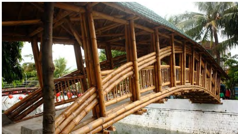
Figura 5. Pod de bambus de 18 m lungime- Indonezia.[12]
