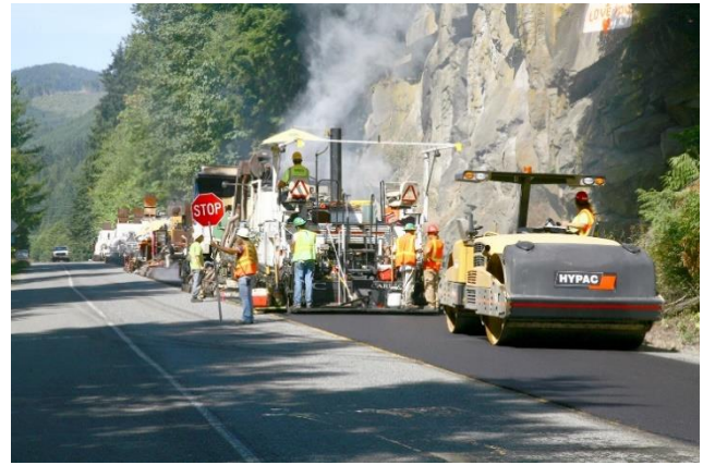
Fig.2 Acoperirea cu covor asfaltic
