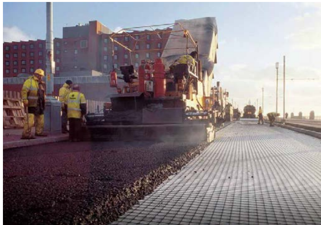
Fig.1 Așezare material geosintetic
