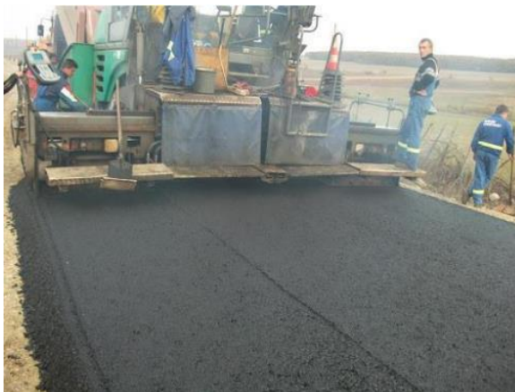
Fig.5 Așternere mixtură asfaltică
