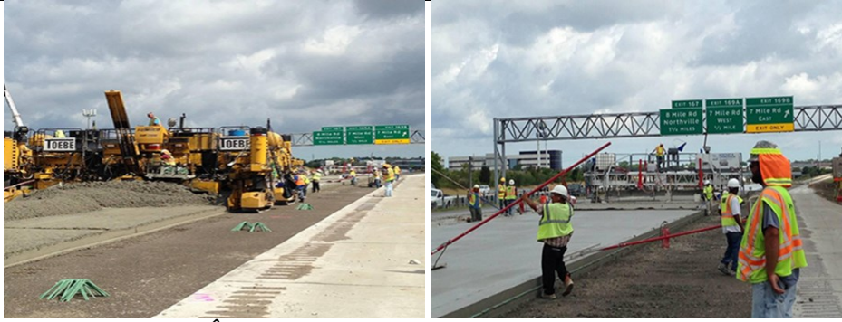
Figura 1-6. Înlocuirea dalelor de beton la autostrada I-275 [39]
