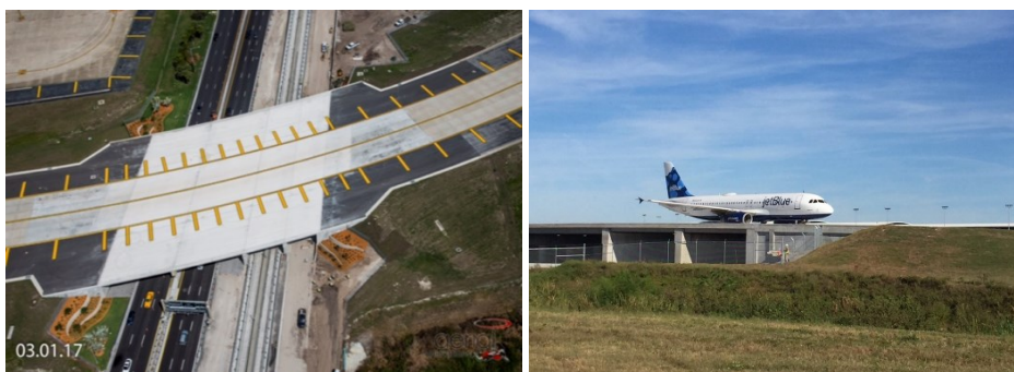
Figura 1-8. Reconstrucția podului "J" Aeroportul Internațional Tampa [41]
