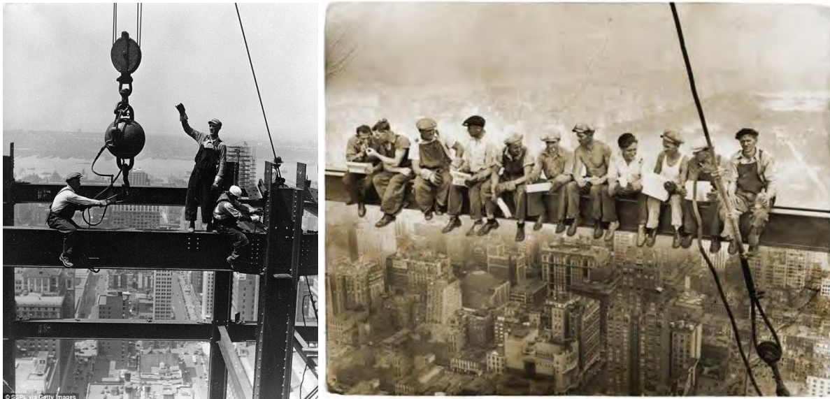
Fig. 9 Muncitori ce lucrează la înălțime la construcția unui zgârie-nori, USA anii 1930. Epoca concrete/steel 1900-1960 [ Lunch atop a Skyscraper ].
