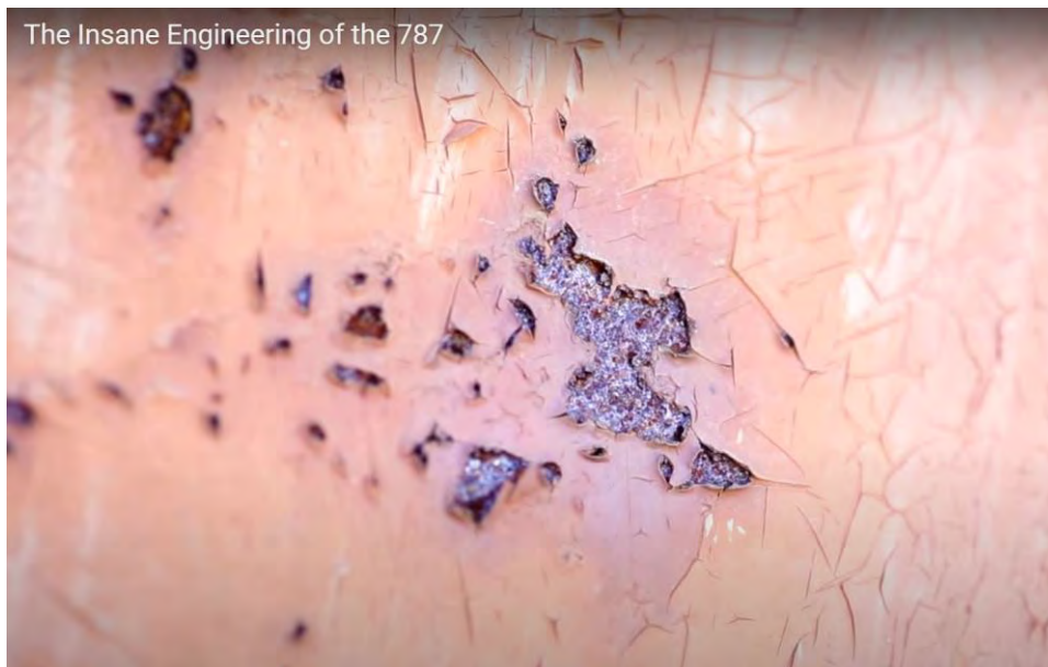
Fig. 224 Fenomene de microfisurare la oboseală în structura de aluminiu din jurul ferestrelor la avioane.
