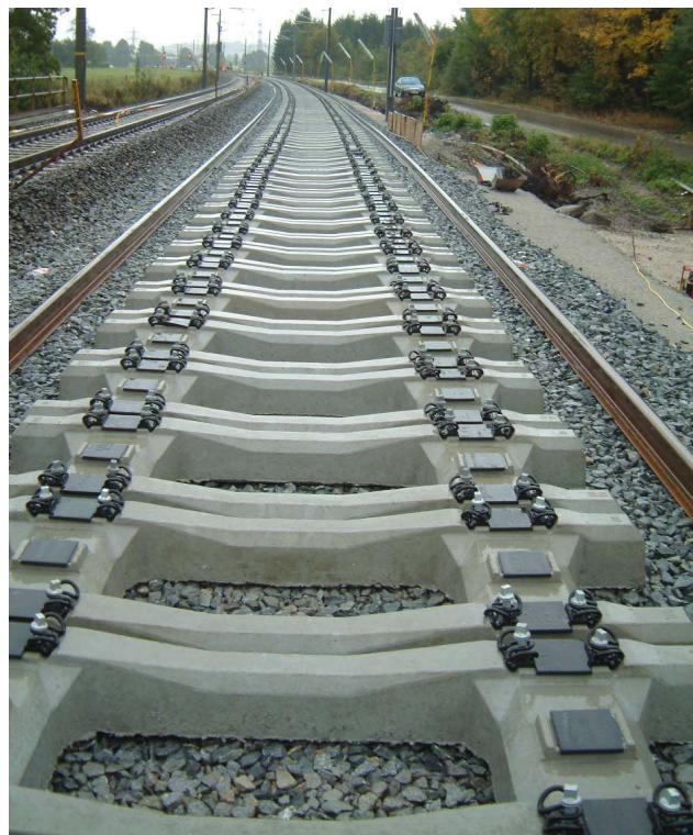
Figura 2.26 Așezarea traverselor cadru [21]
