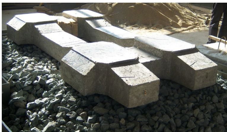
Figura 5.9 Traversa cadru așezată pe prisma de piatră spartă
