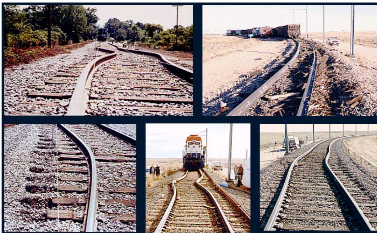
Figura 4.107 Cazuri de pierdere a stabilității prin șerpuirea căii în plan orizontal [70]
