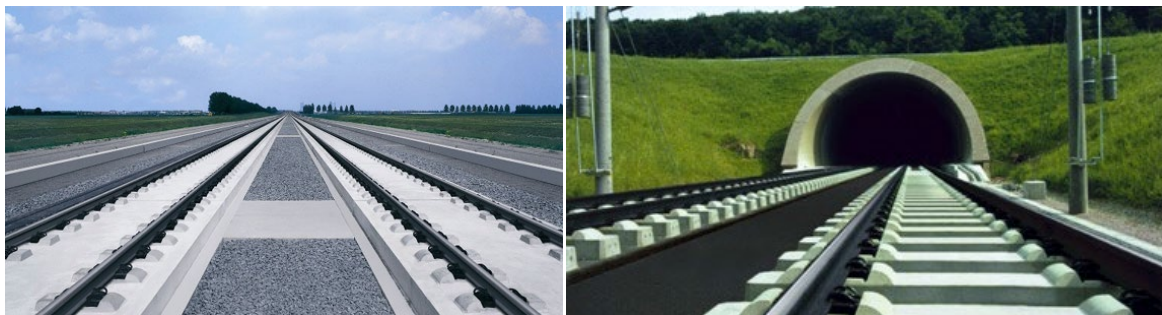
Figura 2.14 a, b Sisteme tip Rheda [18]
