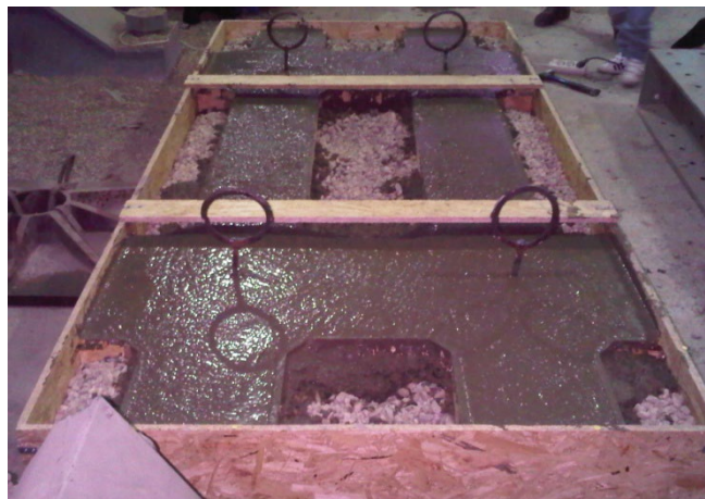
Figura 5.5 Betonul proaspăt turnat
