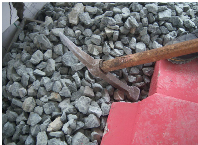
Figura 5.10 Compactarea manuală a prismului
