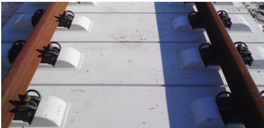
Figura 1.2 Calea înglobată în beton [6]
