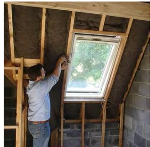
Figura 8. Montarea izolației din lână
