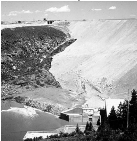
Figura 7. Secvența de defecțiune a barajului Teton, infiltrația se extinde
