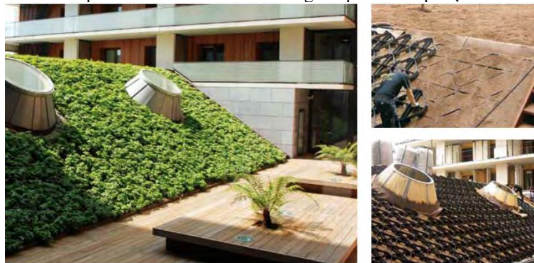
Figura 5. Rețea de tip ecoraster pentru acoperișuri verzi înclinate [5].
