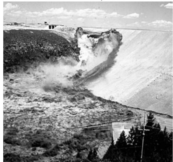
Figura 8. Secvența de defecțiune a barajului Teton, eșecul barajului
