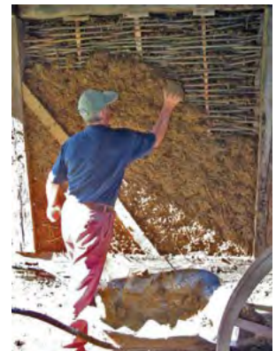
Figura 5. Aplicarea tencuiei de lut
