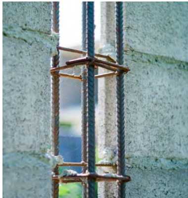
Figura 9. Stâlpișori din beton armat
