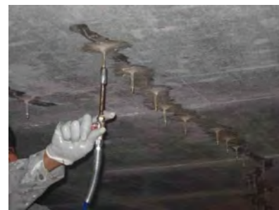
Figura 7. Injectare cu rășină epoxidică
