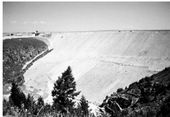
Figura 6. Secvența de defecțiune a barajului Teton, eroziune inițială
