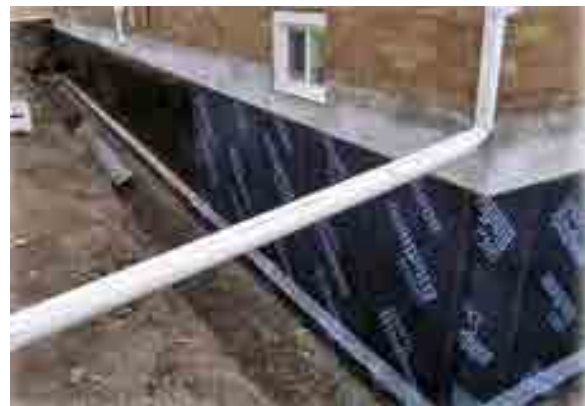
Figura 2. Hidroizolație pentru fundație [6].
