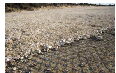
Fig.7-Armare strat fundație
