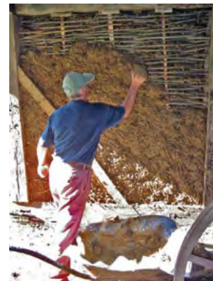
Figura 5. Aplicarea tencuiei de lut
