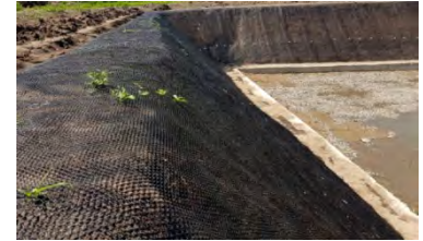
Fig. 9-Pantă instabilă
