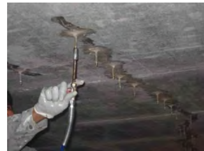
Figura 7. Injectare cu rășină epoxidică
