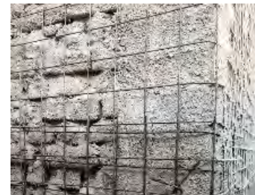
Figura 8. Tencuială armată cu oțel
