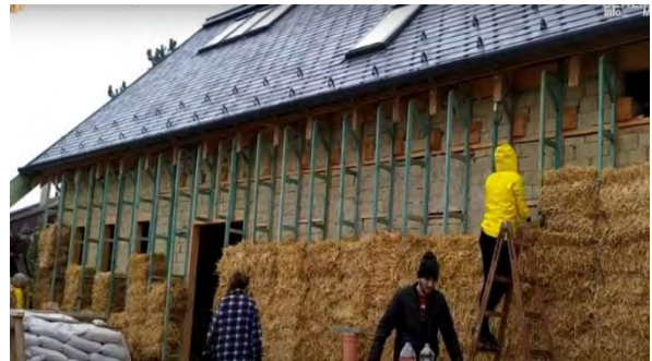
Figura 6. Baloți de paie în construcții
