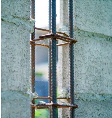
Figura 9. Stâlpișori din beton armat
