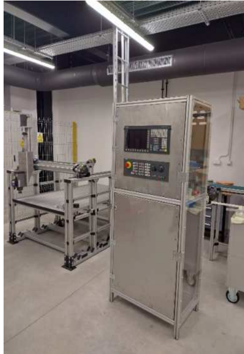
Fig. 5.11 Dulap automatizare router CNC - închis
