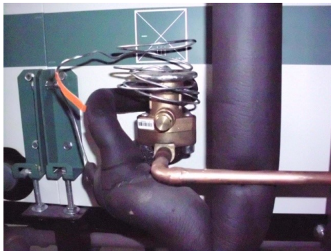
Fig.8.6 – Izolarea conductei de vapori reci la ieșirea din vaporizator
