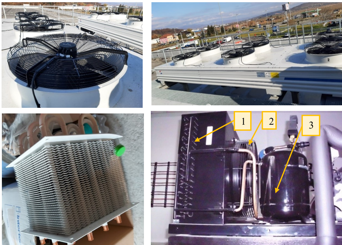
Fig.5.29 – Condensator de tip baterie de serpentine cu lamele:
