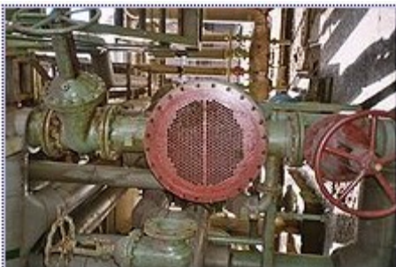
Fig.5.10 – Schimbător de căldură cu fascicul tubular „U” [38]
