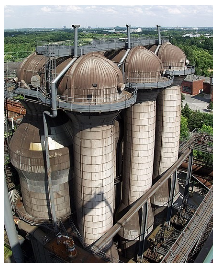
Fig.6.3– Schimbător de tip Cowper [51]
