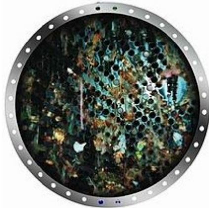
Fig.5.9 – Colmatarea țevilor unui schimbător dintr-o termocentrală [38]
