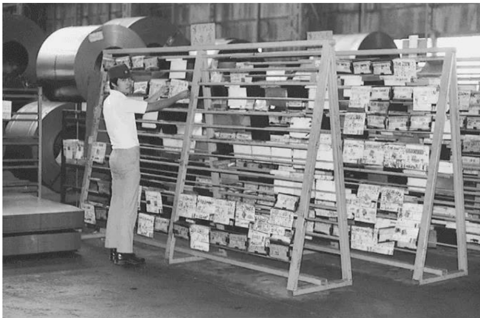
Fig. 7.1. Exemplu de aplicare a sistemului Kanban la Toyota [75].
