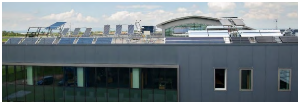
Fig.8.10. Standuri de cercetare pentru sisteme solar-termice și fotovoltaice pe terasa clădirii centrului de cercetare RESREC în Institutul de Cercetare Dezvoltare al Universității Transilvania din Brașov
