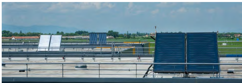
(f) Colectoare solar-termice pentru producerea apei calde menajere în ICDT
