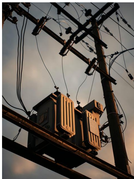
Figura 16.2. Post de transformare poziționat la înălțime
