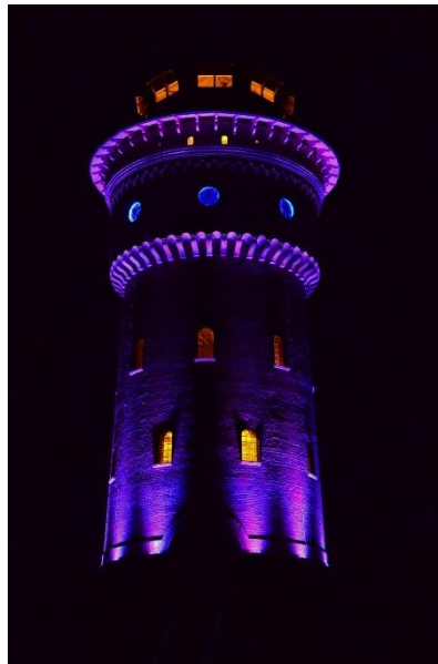
Figura 4.11 Aparat de iluminat dedicate iluminatului architectural
