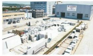
FABRICA DE PREFABRICATE
