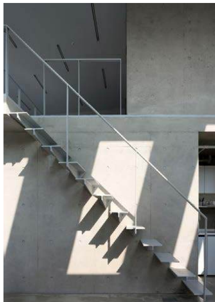
SCARA DIN PROFILE METALICE INCASTRATE
