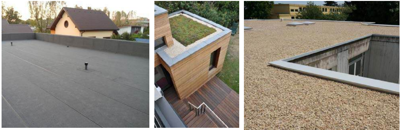
Figura 71: Exemple de rezolvare a teraselor necirculabile
