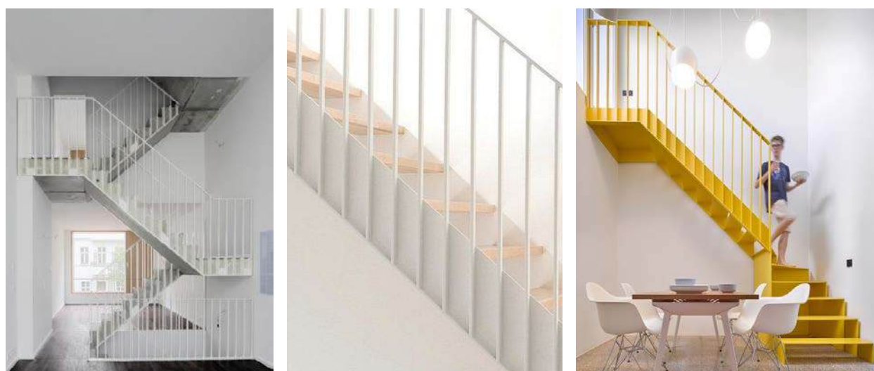
Figura 34: Parapet din elemente verticale
