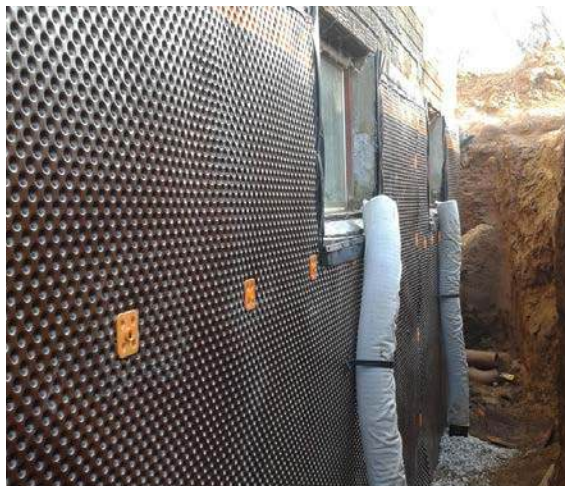
Figura 2: Protejarea hidroizolației cu membrană Tefond
