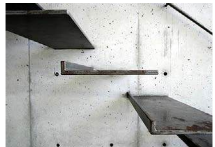
SCARA DIN PROFILE METALICE INCASTRATE
