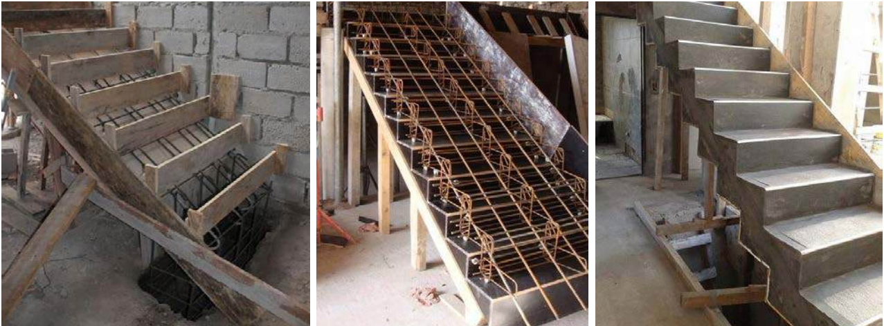
Figura 31: Tipuri de armare la scara de beton
