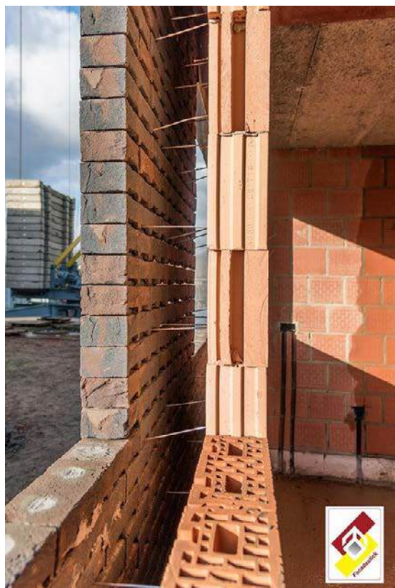
Figura 58: Exemple de montaj la fațade ventilate din cărămidă aparentă
