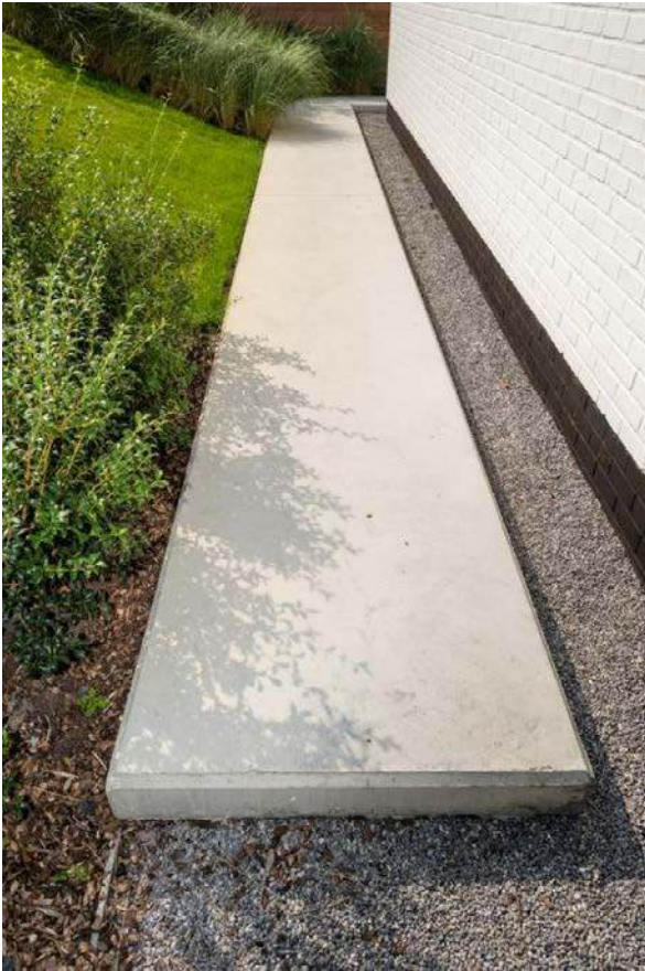
Trotuar de garda din beton si rigola de pietris
