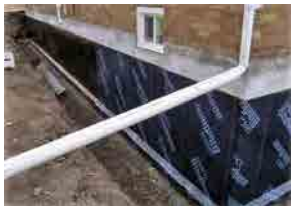
Figura 2. Hidroizolație pentru fundație [6].
